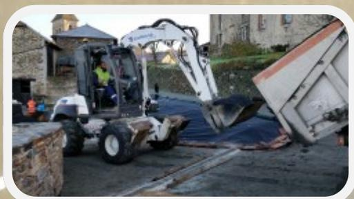
L'entreprise CHAVINIER pour le compte du S.D.E.C. (syndicat départementale d'énergie du cantal) a procédé à l'installation de 5 candélabres. L'entreprise CAUMON NAU a réalisé les travaux de voirie : décaissement, empiérement, pose de regards de récupération d'eaux pluviales.
