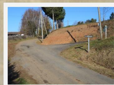
**La Vaysse :** réalisation drainage en pied de talus, reprofilage et revêtement tri-couche.
