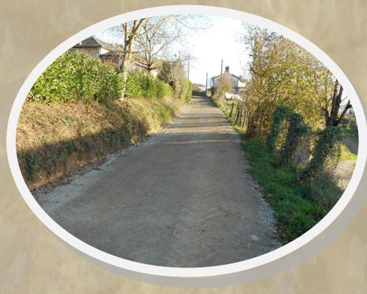
**Montserat : décaissement pour élargissement virage, empiérement bord de route 0/31.5 compacté et revêtement tri-couche et pose de balise pour protection de la maison.**
